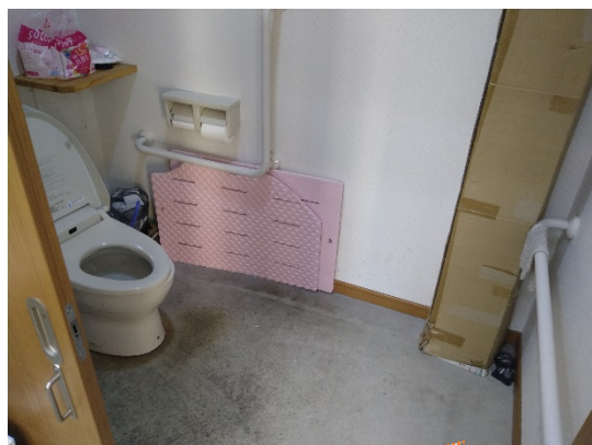
改修工事前のトイレ
